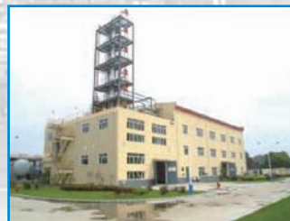
异戊橡胶中试装置
