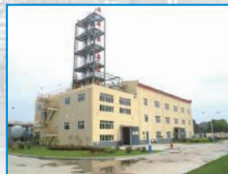
异戊橡胶中试装置
