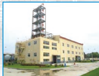
异戊橡胶中试装置
