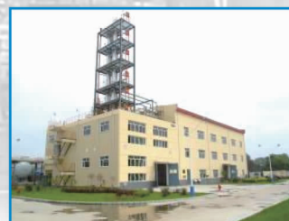
异戊橡胶中试装置
