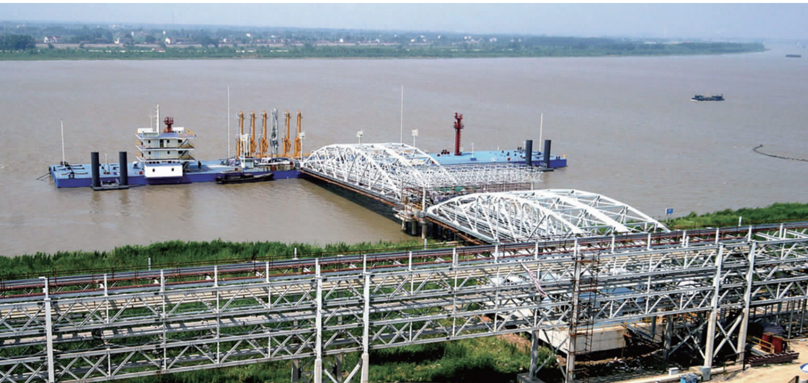
南京化工园区液体化工码头
