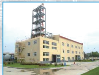
异戊橡胶中试装置
