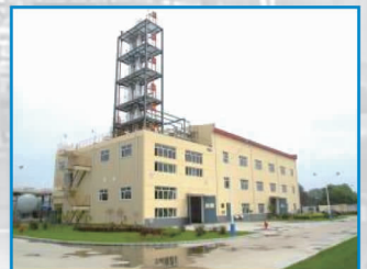
异戊橡胶中试装置
