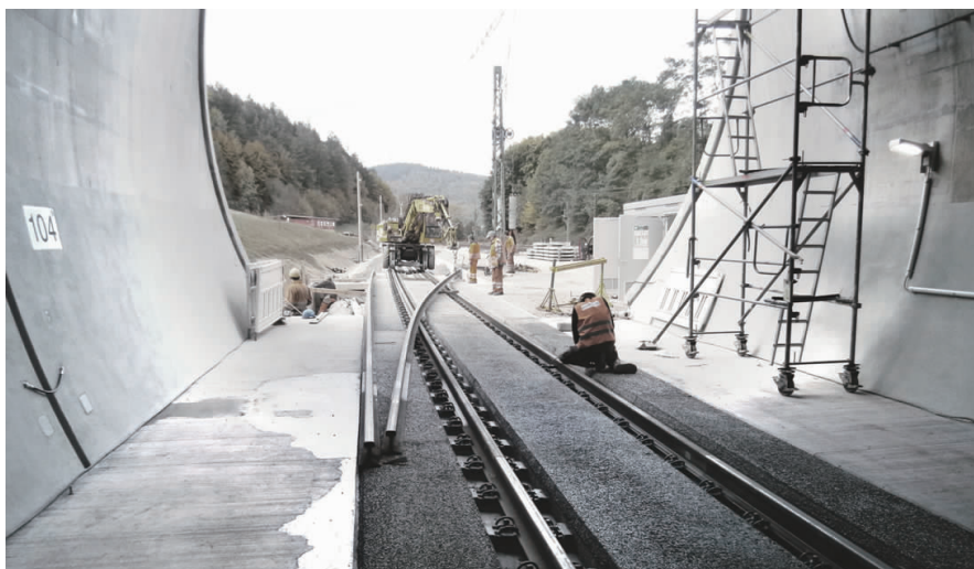
Bebenroth 隧道试点项目：轨道之间及四周均铺设了经 ETONIS® 260 改性的排水混凝土。如果有水溢出，就能通过混凝土向四周排水，确保事故发生时救援车和消防车一路畅通无阻地进入铁路隧道。（图片由 Siegfried Riffel 提供，版权归海德堡水泥公司所有。）
