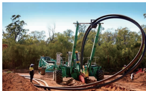
同时犁入铺设 2 条 315mm PE 管
