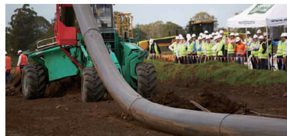
图 3 Murphy 犁入铺设 630mm PE 管
