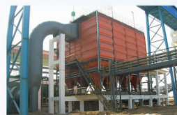
KBDW干法卧式静电收尘器
