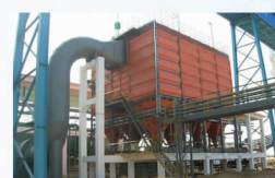
KBDW干法卧式静电收尘器
