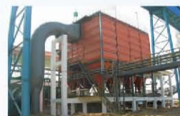
KBDW干法卧式静电收尘器
