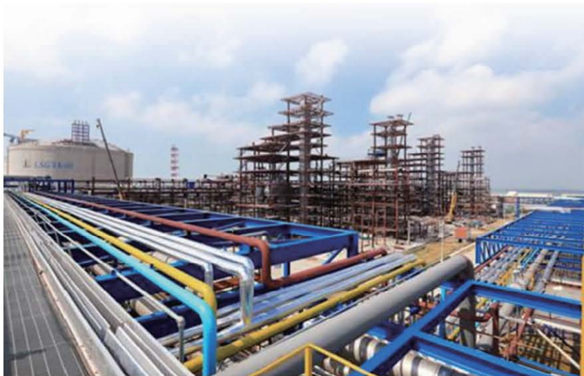
国内首套LNG轻烃回收装置施工现场
