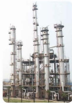
湖北汉兴科技有限公司脱丙烷塔、吸收解吸塔
