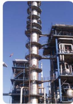
齐鲁石化污水汽提塔
