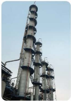
洛阳炼化宏达实业有限公司碳四萃取精馏塔
