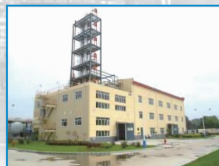
异戊橡胶中试装置
