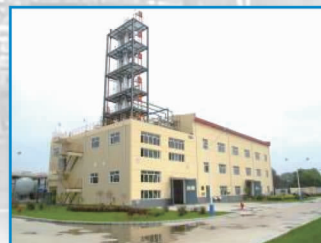
异戊橡胶中试装置
