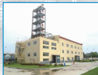
异戊橡胶中试装置
