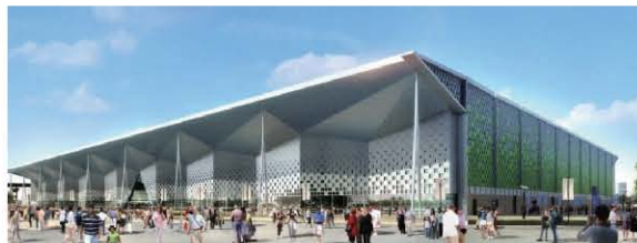
◆ 上海世博主题馆其钢结构防腐工程展开面积约为11万平方米,全部使用了裕祥涂料,整个配套油漆设计使用寿命15年
