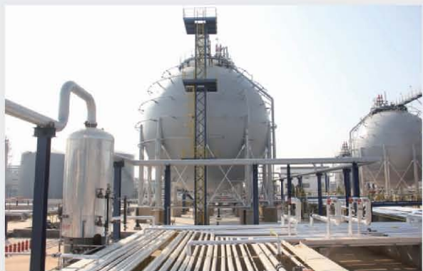
乙烯罐和丙烯罐
