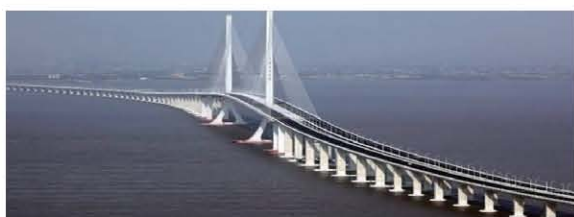
◆ 上海长江隧桥防腐涂装工程由上海开林造漆厂完成配套涂装
