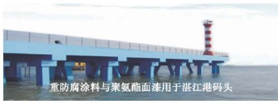
◆ 湛江港码头防腐涂装工程由厦门双瑞船舶涂料有限公司完成配套涂装
