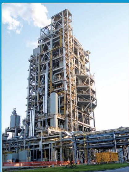
天津煤气化项目装置
