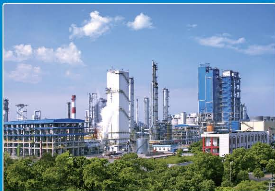
安庆煤气化项目装置
