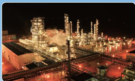
内蒙古煤间接液化项目装置
