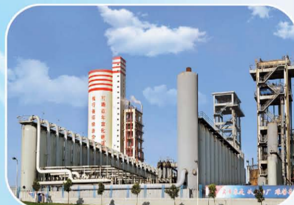
▲ 湖北宜化集团贵州兴义年产40万吨尿素变压吸附脱碳装置
