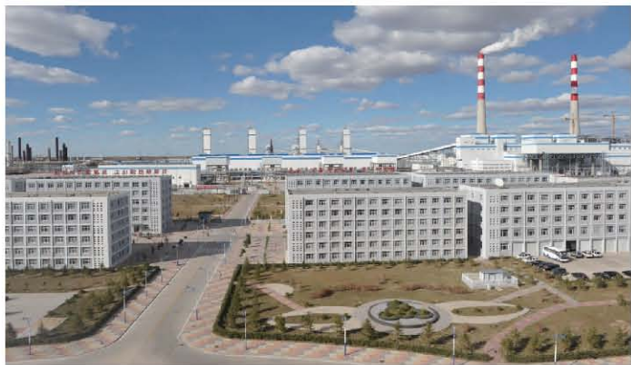
▲大唐克旗煤制天然气项目厂区鸟瞰
