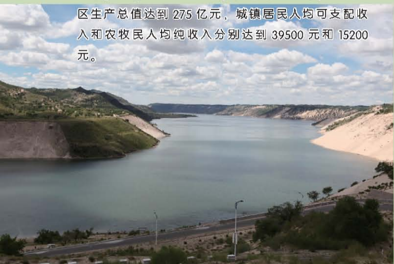
▲ 园区煤化工产业发展水源地——大石门水电站
