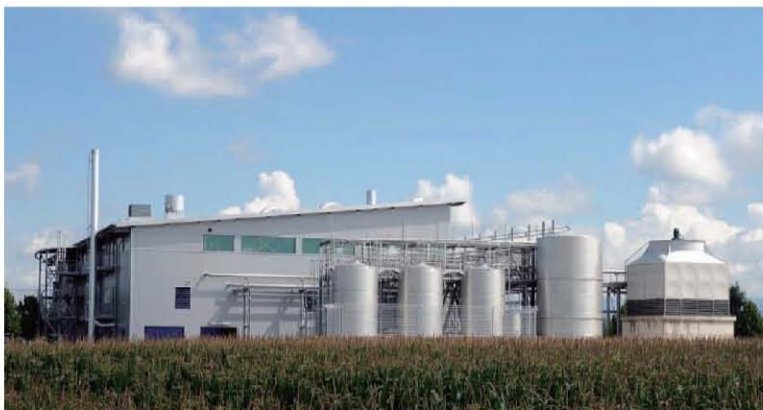
科莱恩 sunliquid® 试点工厂, 使用农作物残留物生产纤维素乙醇。
