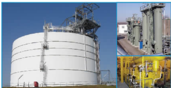
液化天然气 (LNG) 调峰站 2,400立方/小时天然气, 每小时产生4立方液化天然气2,400吨/天
