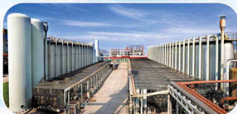
▲ 晋煤集团山东明水化肥厂年产30万吨甲醇变压吸附脱碳装置
